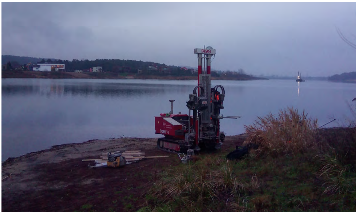
2 pav. Lauko darbai
