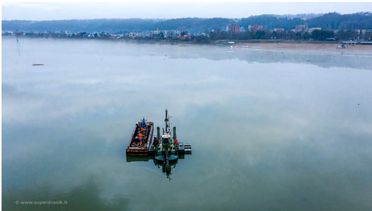
1 pav. Lauko darbai
